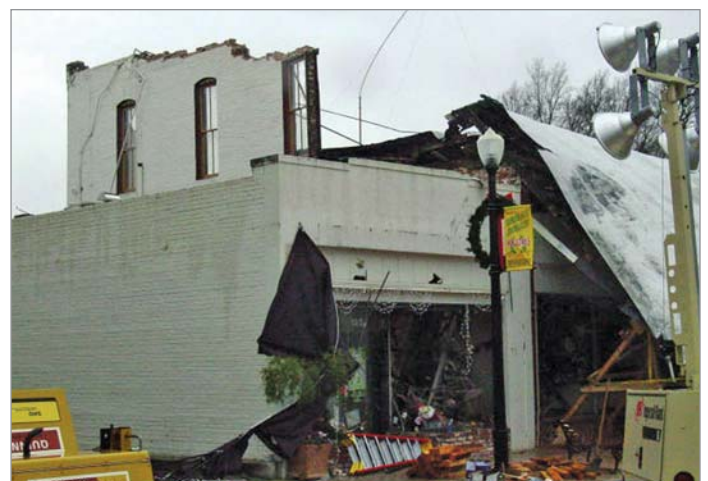
Un techo derrumbado en el centro de la ciudad de Paso Robles después del terremoto de San Simeon el 22 de diciembre de 2003. Dos personas resultaron muertas a causa de los escombros cuando salieron corriendo del edificio. (Foto USGS)
